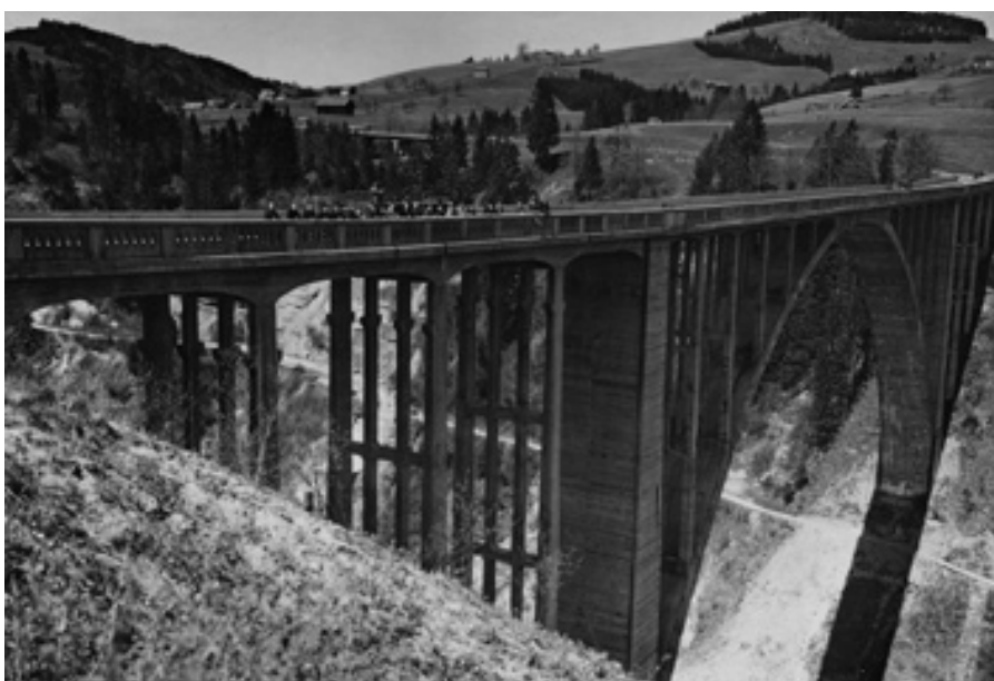
Bild 14 Auf der Hundwi- ler Tobelbrücke
